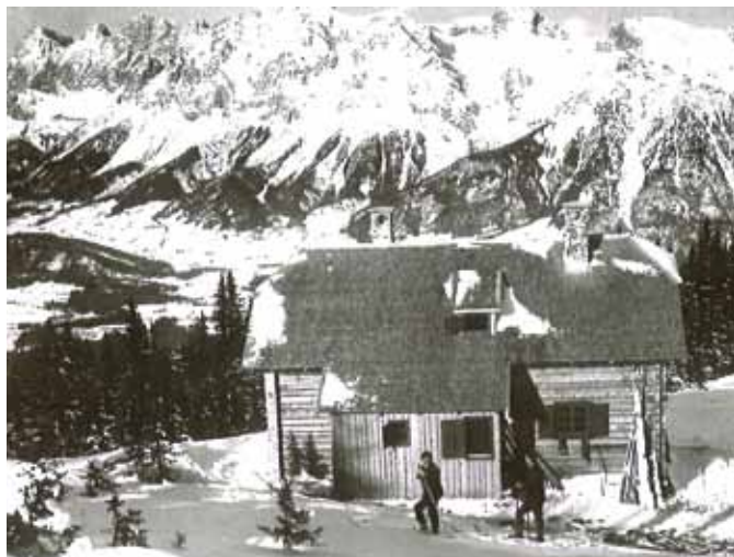
Die Schladmingerhütte kurz vor ihrer Fertigstellung im Jahr 1926.
