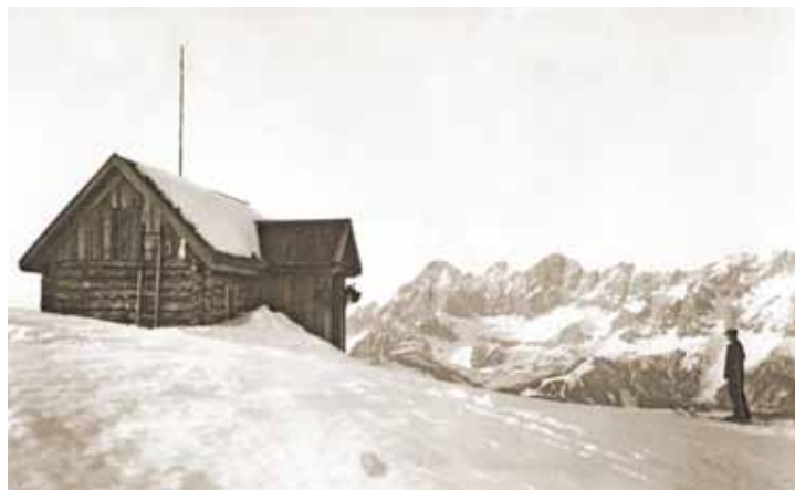
Die Hochwurzenhütte, erbaut 1920.
