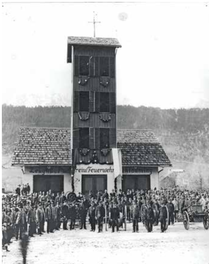
Das 1903 errichtete Rüsthaus der Freiwilligen Feuerwehr Schladming.
