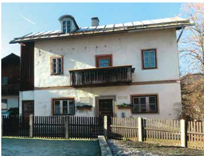
Ostansicht des Hauses in der Griesgasse 127. Erkennbar sind die typischen Merkmale einer Clüftung mit Zugspange.
